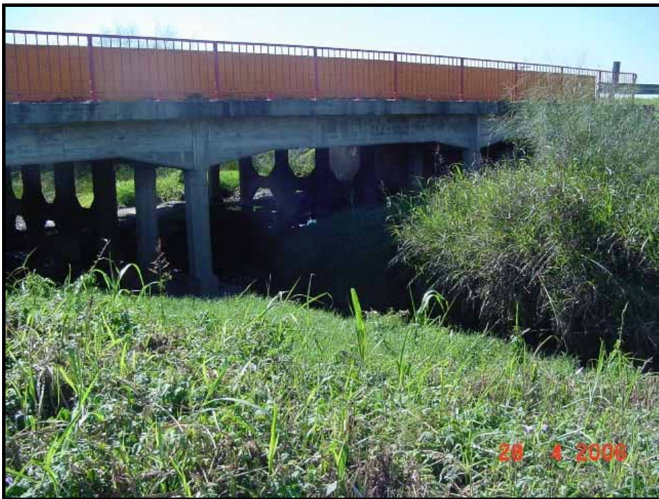
Figura 22.- Puente sobre arroyo Colastiné.
